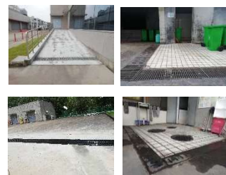
各场所拦截污水的明沟
