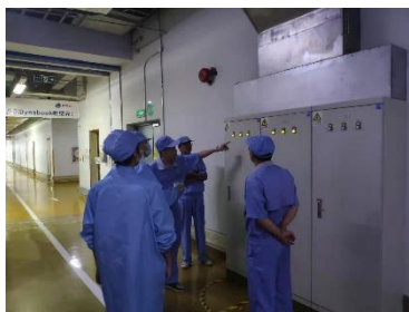
电气安全检查
