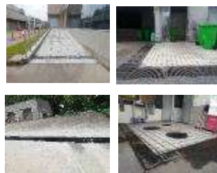
各场所拦截污水的明沟
