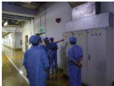
电气安全检查
