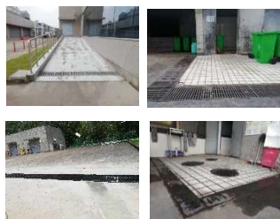
各场所拦截污水的明沟
