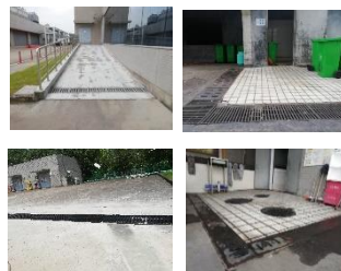
各场所拦截污水的明沟
