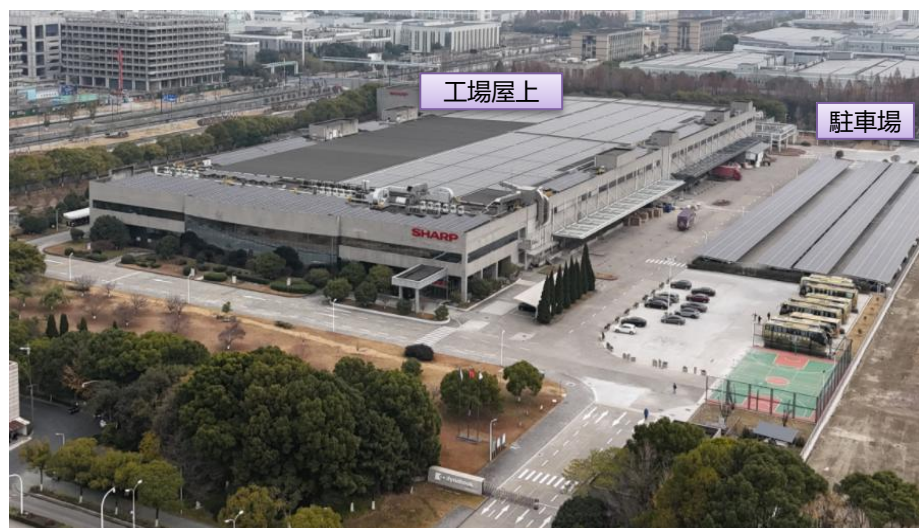
太陽光発電設備
