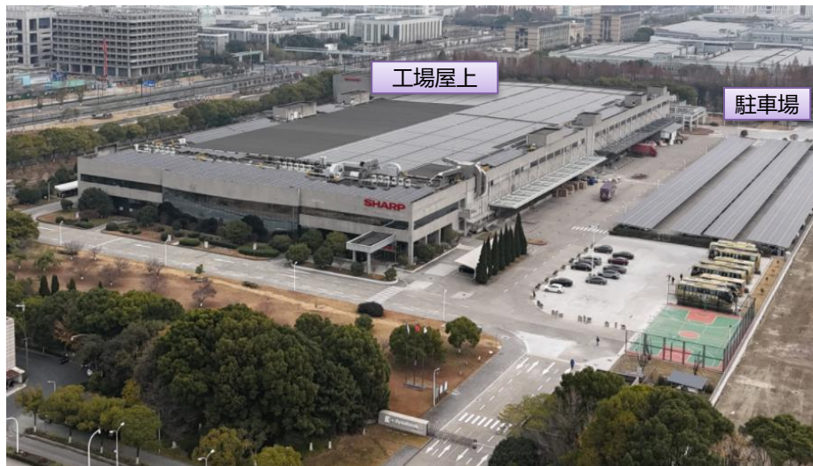
太陽光発電設備
