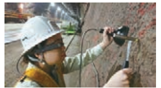
「健コン診断 AR」を使用した コンクリート打音検査
